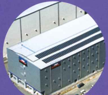
ソーラー発電装置を備えた 本社物流センター
